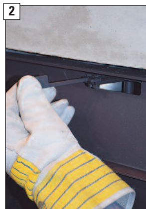
2 Verbrennungsluftschieber auf Befestigungsklemme aufstecken.
