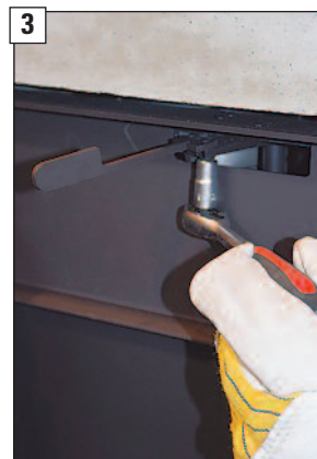
3 Befestigungsschrauben handfest anziehen.
