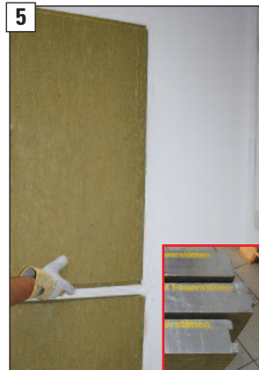
5 Doppelfederplatte in die Nutplatte einstecken und ...
