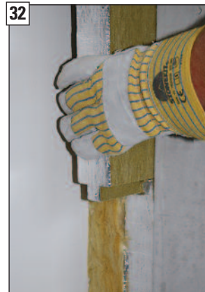
Doppelfederplatte in die Nutplatte einstecken.
