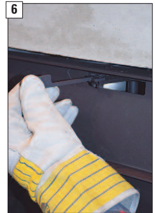
6 Verbrennungsluftschieber auf Befestigungsklemme aufstecken.
