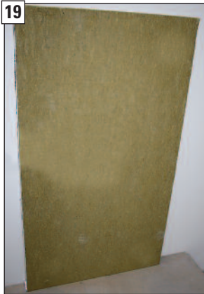
19 Untere Nutplatte des Spezial-KINGFIRE-Rückwanddämmsets an der Innenwand befestigen.
