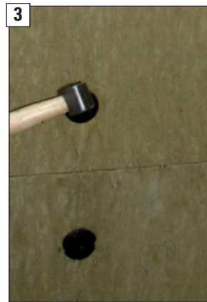
3 ... mit geeigneten Dämmstoffnägeln befestigt werden.
