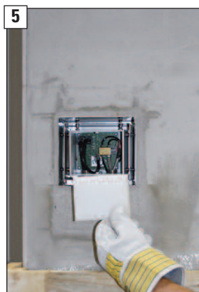
5 Schutzschwamm entfernen.
