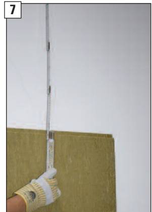
7 Differenzmaß zur bauseitigen Decke ermitteln.
