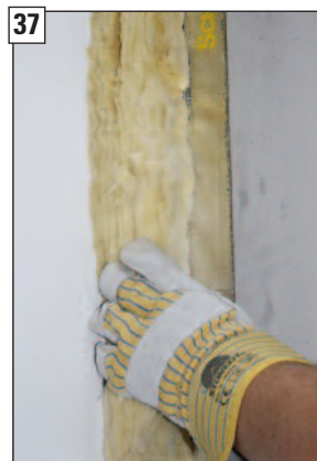
Bauseitige Dämmung zwischen der eingebrachten oberen Nutplatte und der Innenwand einbauen.
