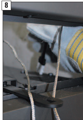
8 Fühlerkabel des Temperatursens- sors (A) seitlich zwi- schen Brennkammer und Feuerstättenmantel nach unten zum Öffnungsbe- reich der Zuluftöffnung der Brennkammer führen.
