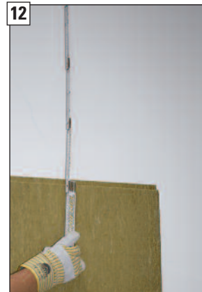
Differenzmaß zur bauseitigen Decke ermitteln.
