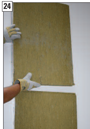
24 Obere Nutplatte in die Doppelfederplatte einstecken.
