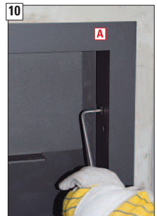
10 Verlängerten Blendrahmen A bis zur bauseitigen Verkleidung aufschieben und Befestigungsschrauben umlaufend festziehen.
