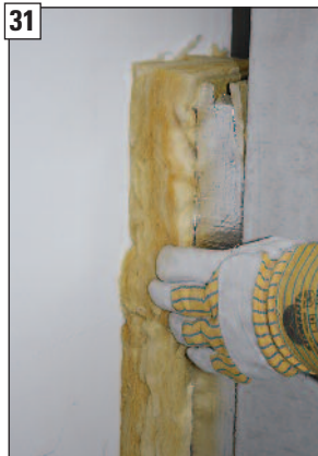
Bauseitige Dämmung zwischen der eingebrachten unteren Nutplatte und der Innenwand einbauen.
