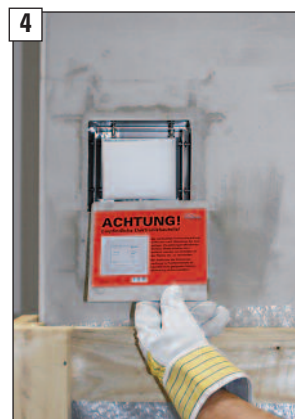
4 Innere Schutzabdeckung entfernen.
