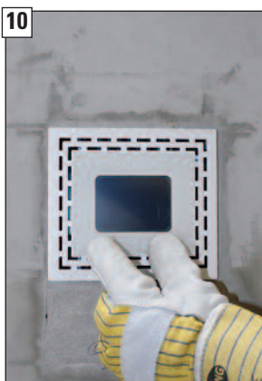
10 LUC-Grafikdisplay in der Steckverbindung des Gehäuses einrasten.
