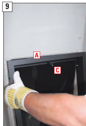
9 Verlängerten Abdeckrahmen A schräg angestellt zuerst über den Verbrennungsluftschieber C fädeln.
