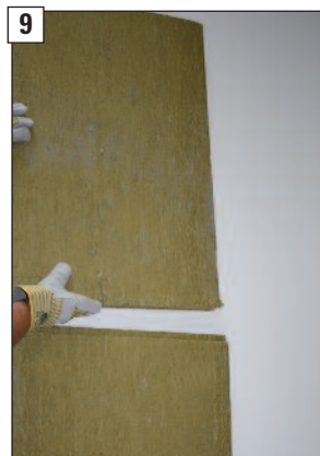
9 Obere Nutplatte in die Doppelfederplatte einstecken.
