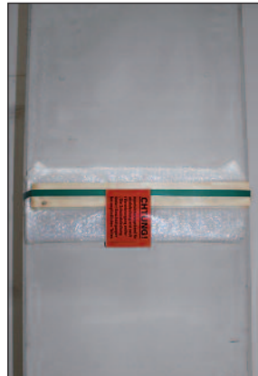
Ansicht der Transportschutzverpackung vor Montagebeginn.
