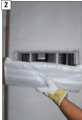
2 Konvektionsluftgitter aus der Montageöffnung entfernen.
