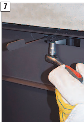
7 Befestigungsschrauben handfest anziehen.
