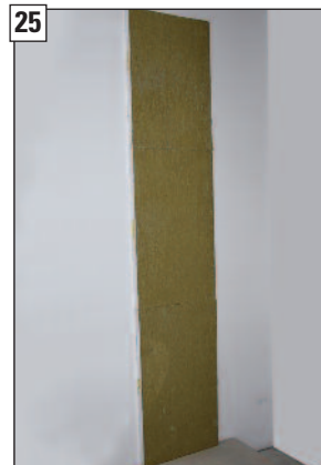
25 Fertigansicht vor Kranversetzen des KINGFIRE-Feuerstättenmantels.
