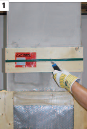
1 Äußere Transportschutzverpackung entfernen.
